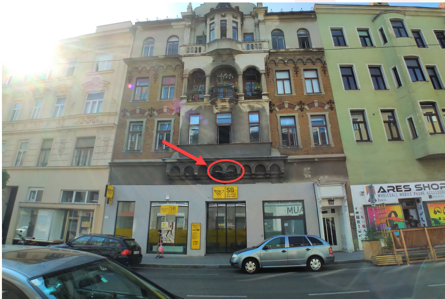
Sechshauser Straße 26, früher Fünfhaus 97. Das heutige Gebäude stammt aus 1896, Foto: Brigitte Neichl 2021
